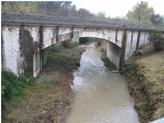
Figure 4 : L'Huveaune à Aubagne (franchissement de la voie ferrée)
